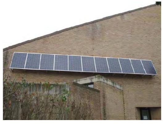
La lunghezza dell'impianto fotovoltaico supera il doppio della lunghezza delle aperture trasparenti sottese.
