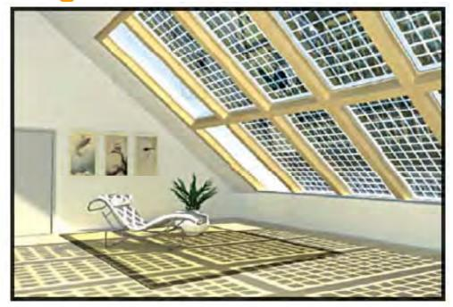
I moduli fotovoltaici trasparenti o semitrasparenti, eventualmente inseriti in sistemi a vetrocamera, sostituiscono superfici trasparenti.
