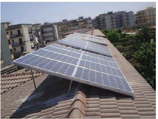
I moduli non rispettano la geometria della falda di copertura.
