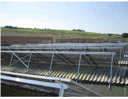
Alcune file di moduli fotovoltaici non sono appoggiate alla superficie di copertura.
