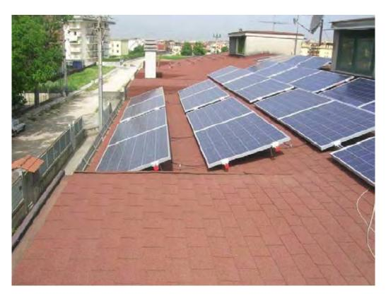
I moduli non sono complanari alla falda di copertura.
